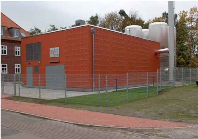
Ansicht BHKW mit Speicher
