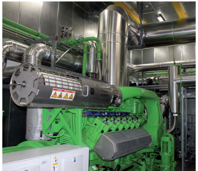
Innenansicht BHKW mit Motor: GE Jenbacher JMS 412 GS, (L x B x H: ca. 600 cm x 180 cm x 220 cm, Gewicht: ca. 13 t)
