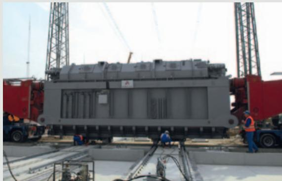
Der 400 Tonnen schwere Transformator für den Ostseewindstrom von Baltic 1 wird zum Umspannwerk Bentwisch bei Rostock gebracht und für die Inbetriebnahme vorbereitet.
