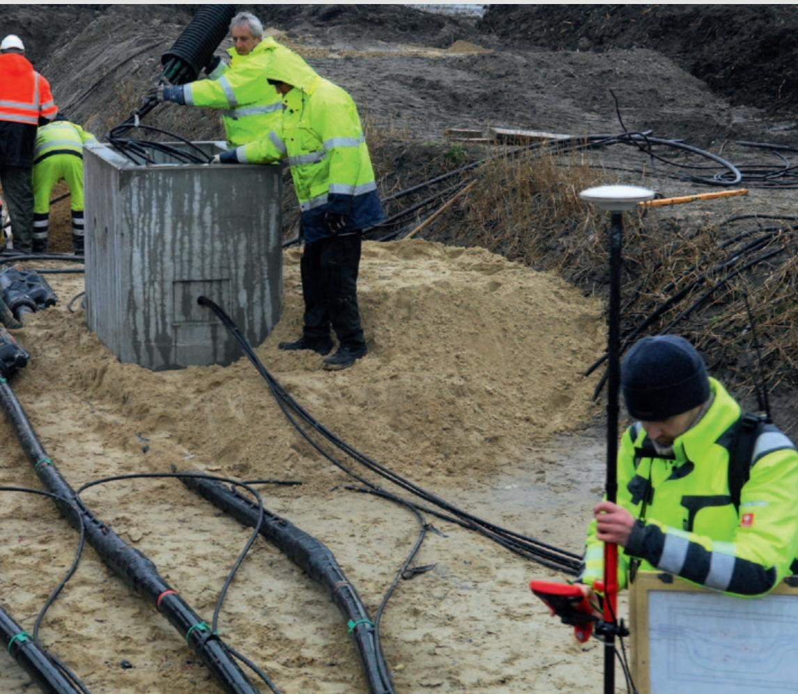
Die Muffen für die Verbindung von See- und Landkabel des Netzanschlusses von Baltic 1 sind fertig montiert.
