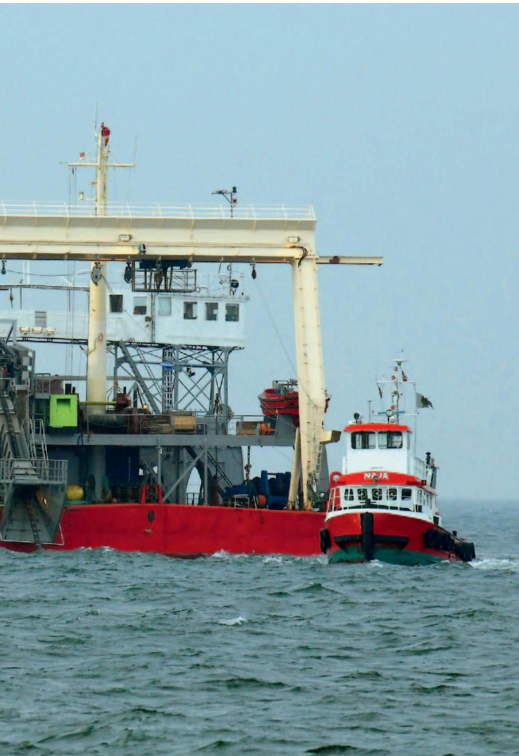
Das Spezialschiff und die Hilfsschiffe legen das Seekabel für den Netzanschluss von Baltic 1 auf der Ostsee. Schwieriger Projektpartner ist das Meer: Die Wellen dürfen während der Arbeiten nicht höher als eineinhalb Meter sein. Das Legen eines 15 Kilometer langen Kabelabschnittes dauert etwa drei Tage.
